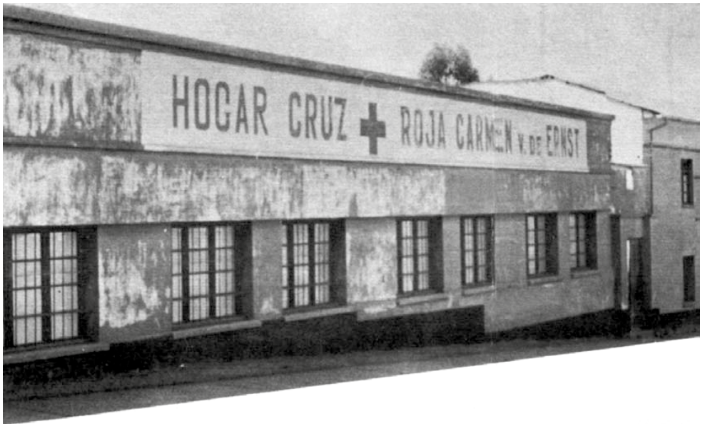
Inmueble donado por el ex alcalde Hugo Ernst, que se convirtió en un hogar de niños y posteriormente en un centro de rehabilitación.
